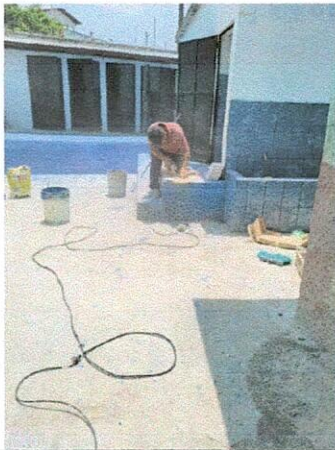
Foto 4: Mejoramiento de área de servicios sanitarios
