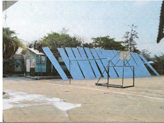
Foto 2: Mejoramiento cubierta de techo
